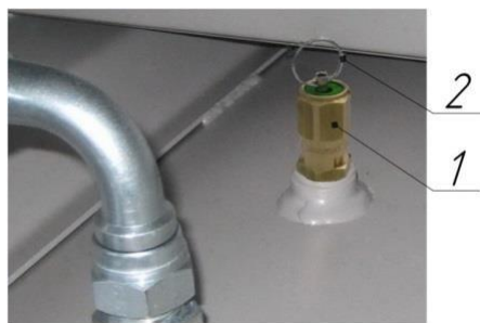
Рисунок 11 – Клапан предохранительный пружинного типа
